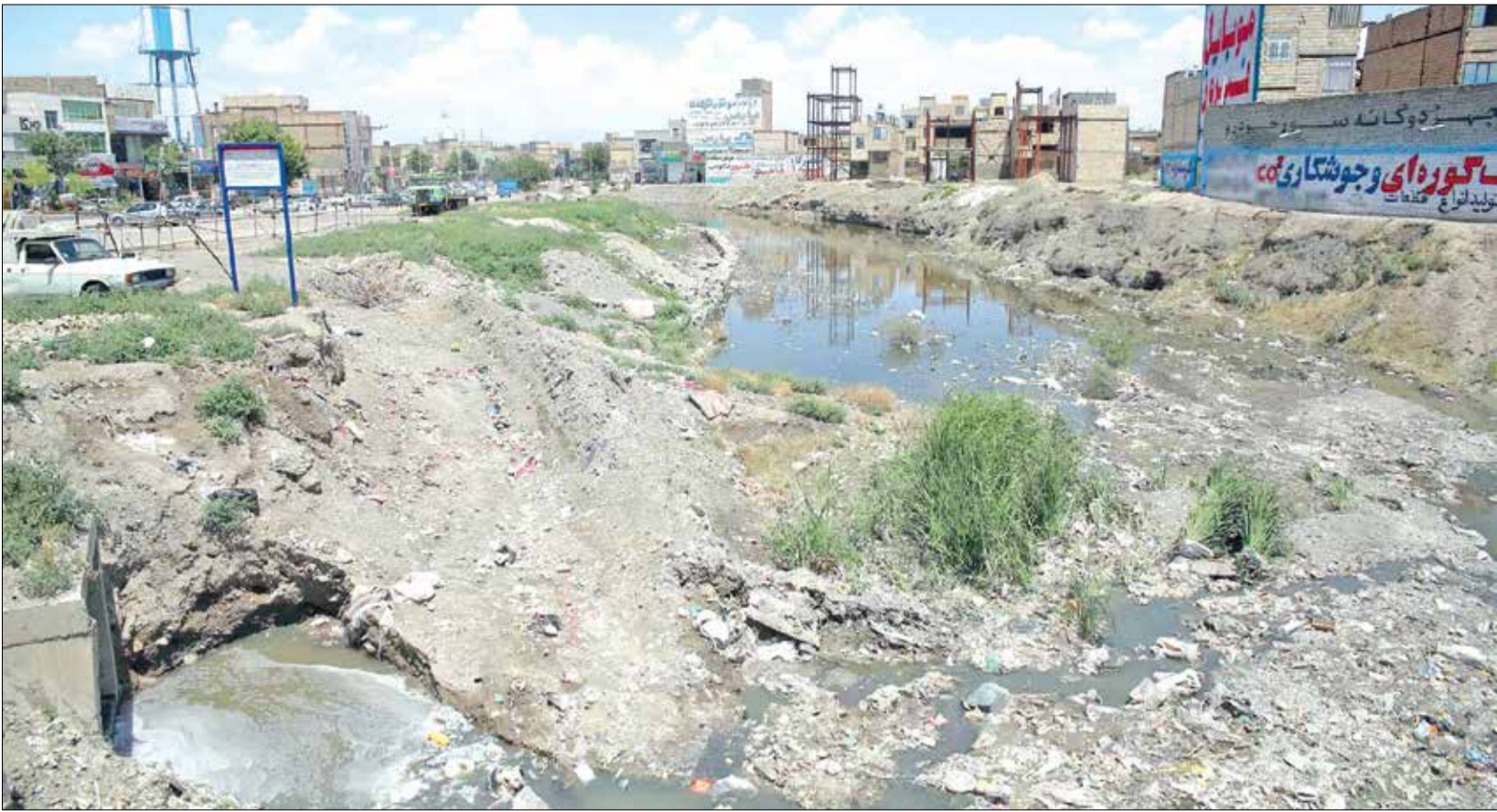
در بازدید از پروژه بهسازی و دیوار کشی کال زرکش مطرح شد:
